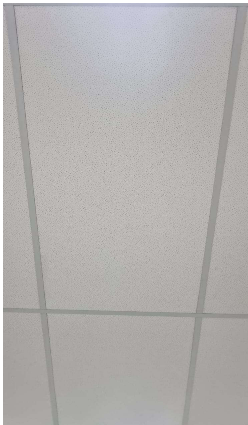
Imagem 3: Detalhe da placa de forro de gesso e estrutura (perfil).
